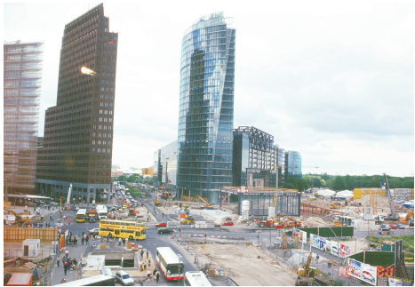
写真 3-15 ベルリンのポツダム広場に完成したばかりのソニーセンター(中央) 右下の箱状の建物は地下鉄入り口(2000年)
