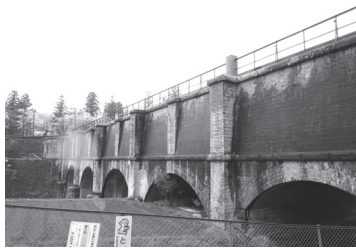
図2-3 登録有形文化財の落合水路橋
