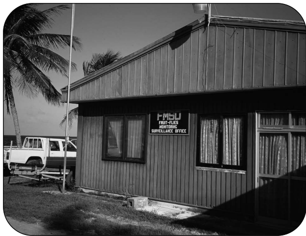
パラオ農業局害虫防除課の建物。すぐ裏手には珊瑚礁の海が広がっています。
